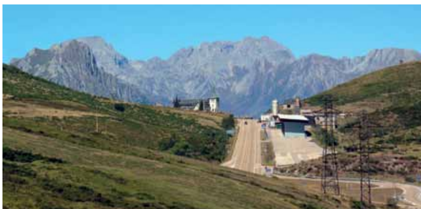
Creuant el mític Puerto de Pajares, entrada d'Astúries, a 1.378 metres sobre el nivell del mar
