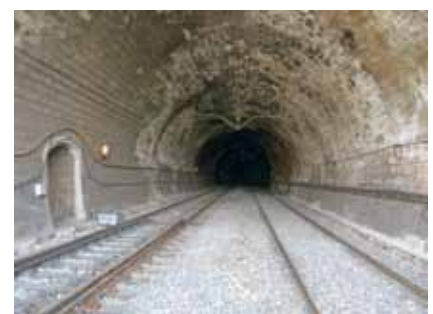
Entrada al fals túnel de l'Argentera
